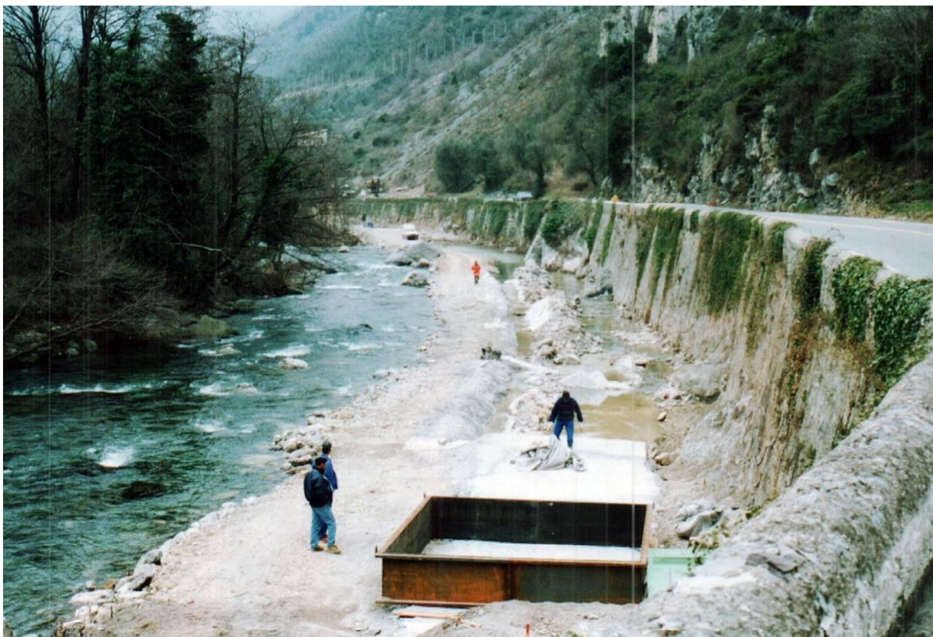
Vues du chantier d'élargissement de la RD 6204, en avril 1993, au stade de la création d'une plateforme de chantier en contrebas du mur de soutènement historique.
