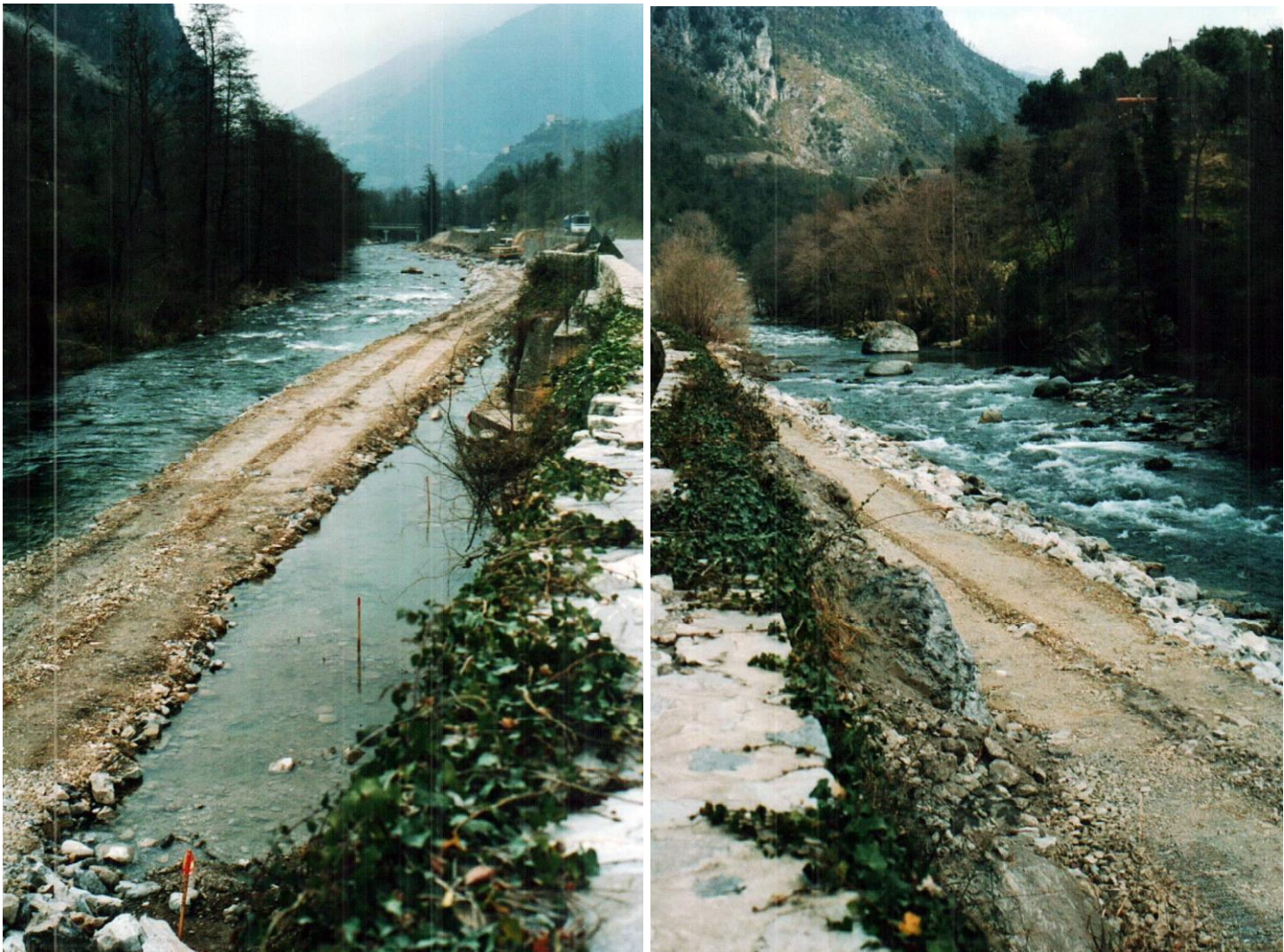
Vues N-S et S-N du chantier d'élargissement de la RD 6204, en avril 1993, au stade de la création d'une plateforme de chantier en contrebas du mur de soutènement historique.
