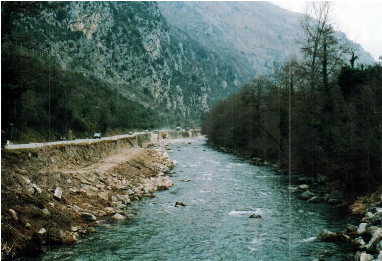
Amont du pont vu depuis le pont .Vue du chantier d'élargissement de la RD6204, en avril 1993, au stade de la création d'une plateforme de chantier en contrebas du mur de soutènement historique.
